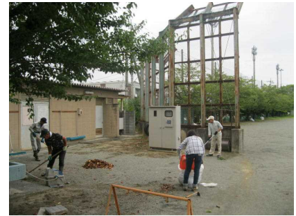
↑地域の方々による除草作業
